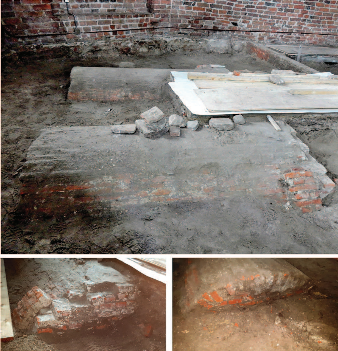
Fig. 12. Boven: de twee bakstenen grafkelders in het oosten van het koor, gefotografeerd vanuit het noorden. Volgens het opschrift op de zerk zijn Coenraad Wolter Ellents en Gesina Oldenhuis in de achterste (zuidelijke) kelder bijgezet. Foto Hidde Boerema. Linksonder: de dichtgemetselde ingang van de noordelijke kelder. Foto F. Bosman. Rechtsonder: de achterzijde van de zuidelijke grafkelder. Foto P. den Hengst.
